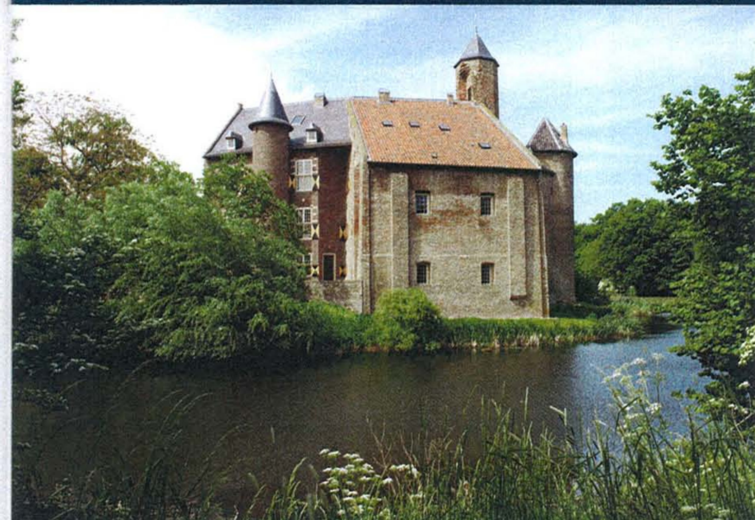
Linkerpagina: Oostvleugel aan de binnenplaatszijde. Voor restauratie.
