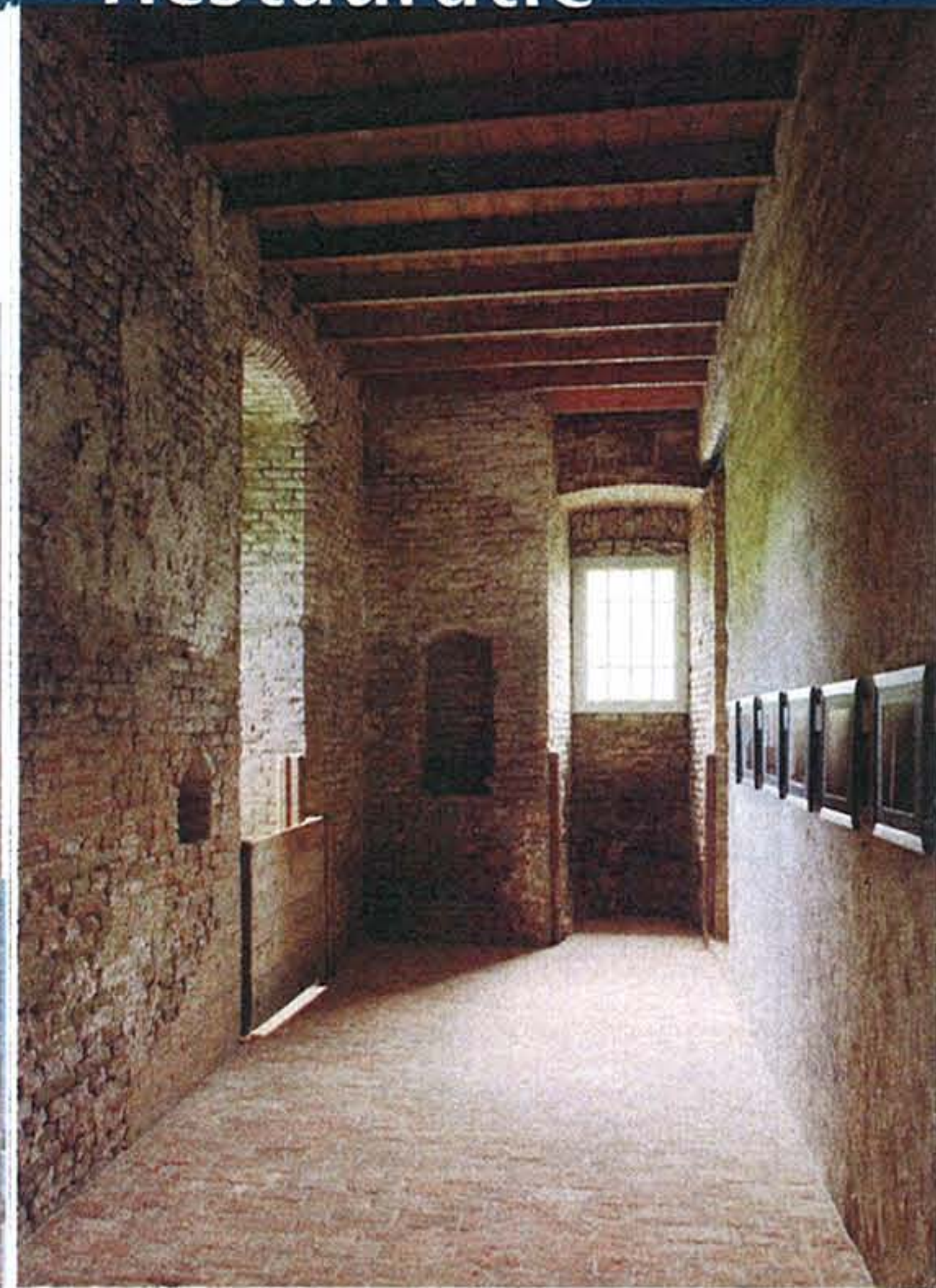
Binnenzijde Donjon (NR). De muurdikte varieert tussen de 150 en 200 cm zoals ook bij kasteel Nederhemert werd aangetroffen. Foto Marco de Nood
